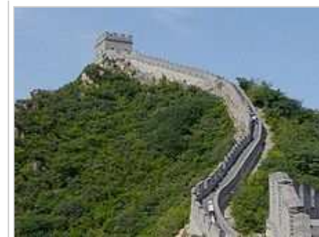
Torre de vigilancia
